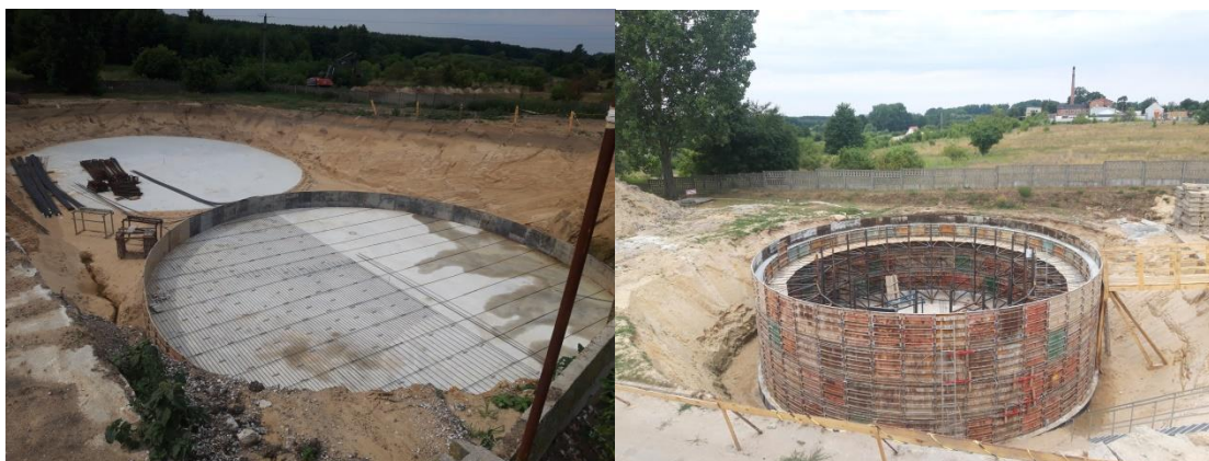
Przebudowa oczyszczalni ścieków w Golinie (etap prac na dzień 19.07.2019r.)
