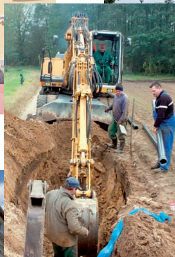
Budowa wodociągu w Kolnie w ramach zadania „Uporządkowanie gospodarki wodno-ściekowej na terenie gminy”
